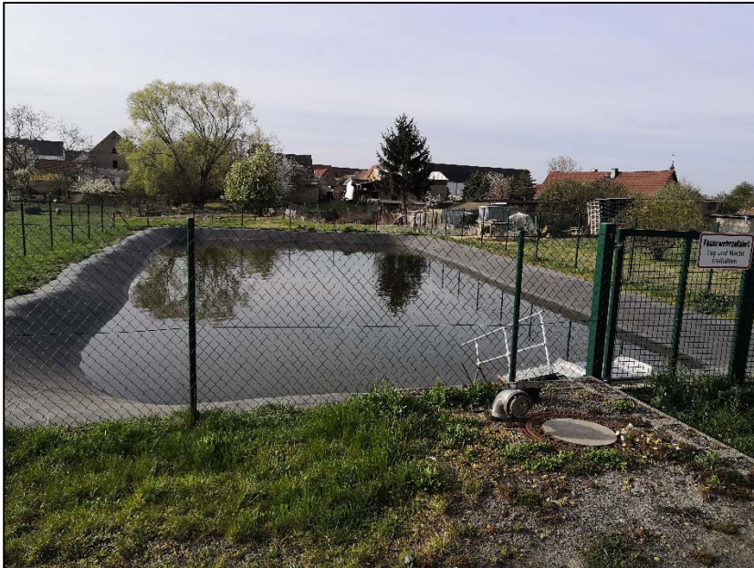
Abb. 6: Löschteich mit abgeflachten Betonwänden
